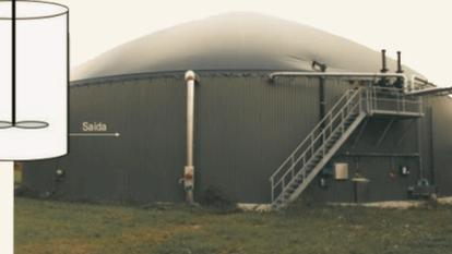
**Figura 10** - Biodigestor CSTR
