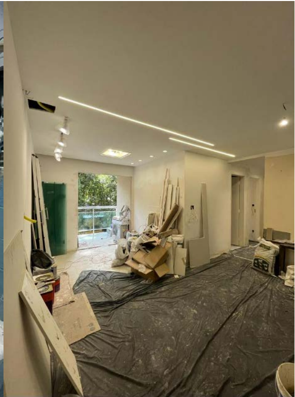
Figura 2: Obra em reforma
