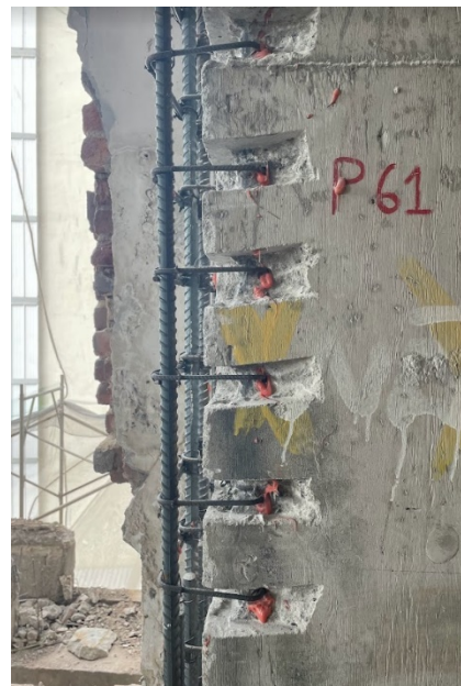
Figura 9 - Exemplo de pilar reforçado na obra de retrofit de 2020 do Hotel Glória
