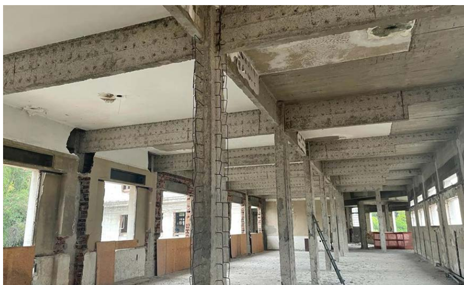
Figura 11 - Imagem de reforços de pilares e vigas em andamento no Bloco 2
