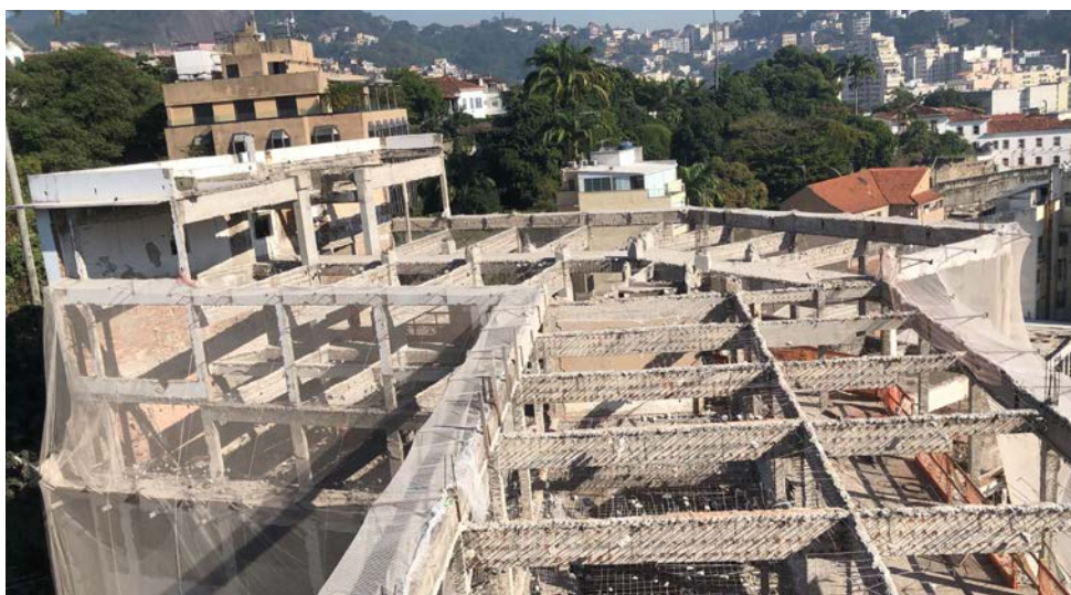
Figura 12a – Imagem das lajes existentes demolidas e as vigas e pilares sendo preparadas para receberem os reforços
