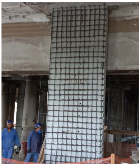
Figura 9 - Exemplo de pilar reforçado na obra de retrofit de 2020 do Hotel Glória
