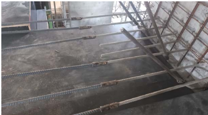
Figura 6a - Imagem de solução de aproveitamento de arranques com luva de emenda soldável.
