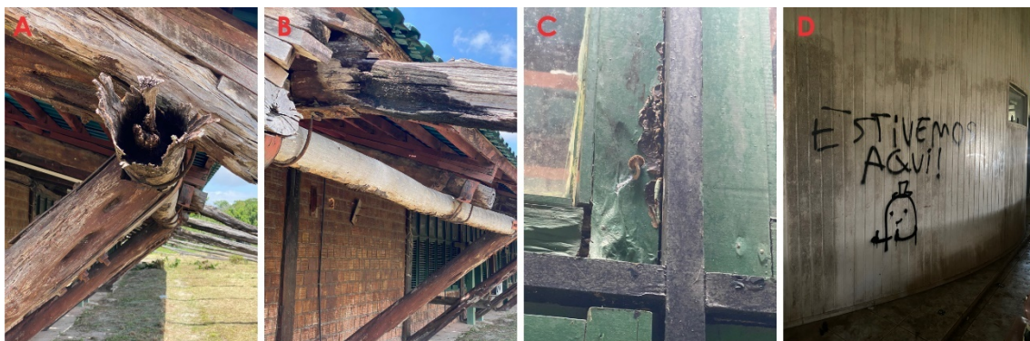
Figura 7 – Manifestação patológicas sobre os elementos de madeira
