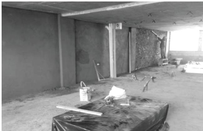
Figura 3 – Emboço sendo executado nas paredes internas do empreendimento
