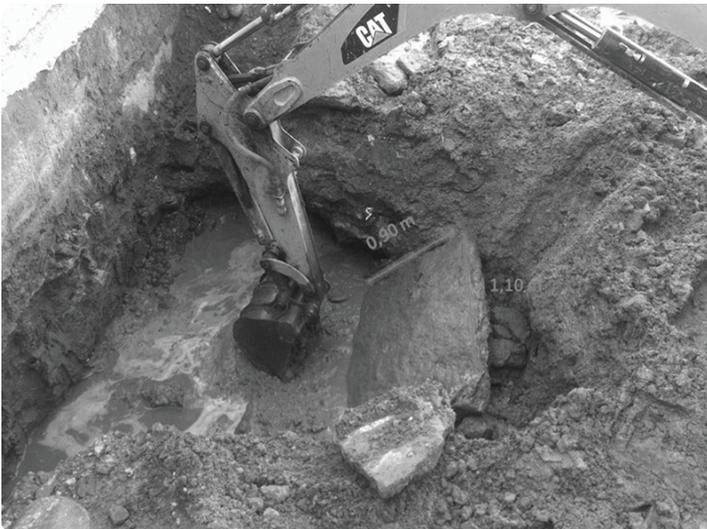
Figura 2 – Retirada de matacões junto ao muro dos fundos
