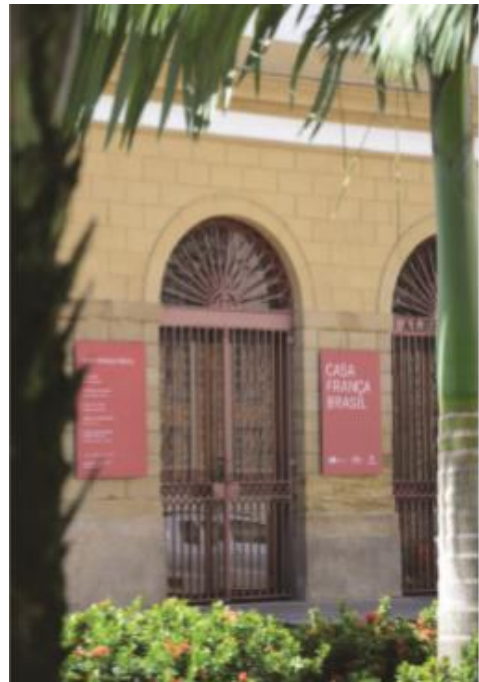
Figura 4 – Características externas: esquadrias em aço
