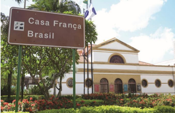
Figura 1 – Fachada restaurada da Casa França-Brasil
