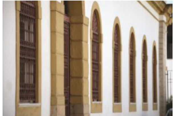
Figura 3 – Processo de restauração da fachada em andamento
