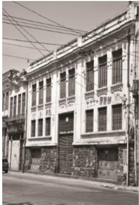
Figura 1 – O galpão: as fachadas serão restauradas
