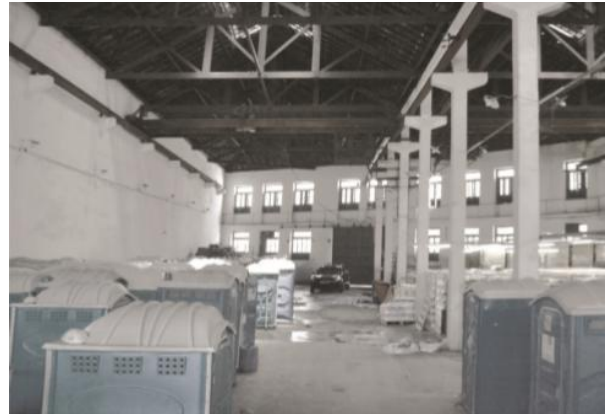
Figura 3 – O interior, descaracterizado ao longo dos anos, chegou a ser depósito de banheiros químicos
