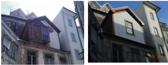
Figura 12 - Reabilitação de uma mansarda
