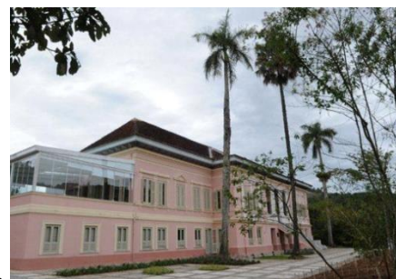
Figura 7 – Vista do Palácio Itaboraí após a intervenção, com o volume prismático já instalado.
