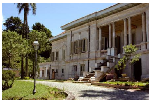
Figura 2 – O Palácio Itaboraí em processo de restauração.
