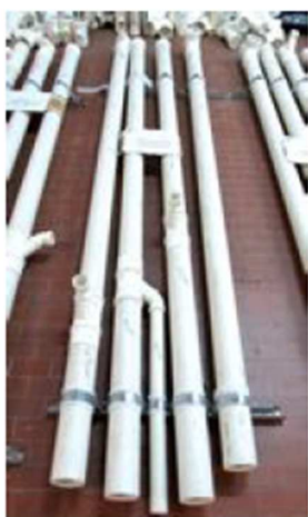
Figura 8 –Tubulação rígida já montada em fábrica
