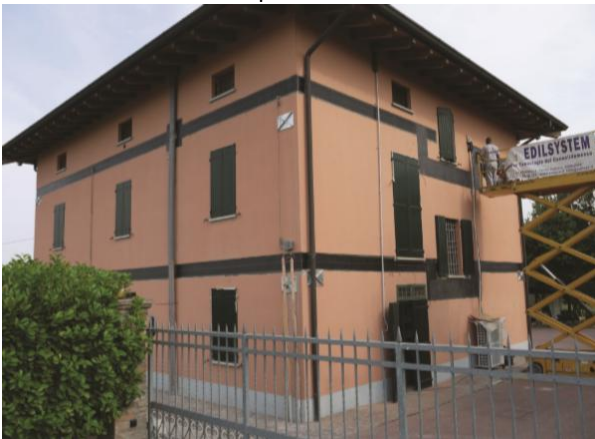
Figura 1 – Evolução tecnológica no restauro : tecido de reforço em fibra de carbono usado na reabilitação predial
