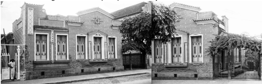
Figura 2 – Fachada principal da Edificação em maio de 1956.
