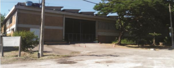
Figura 2 - Foto da fachada do prédio da DFO.
