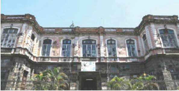
Figura 8 - Situação da Fachada
