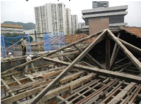
Figura 6 - Recuperação total dos telhados.
