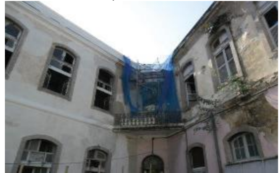
Figura 13 - Recuperação dos revestimentos da varanda dos prédios 01 e 03
