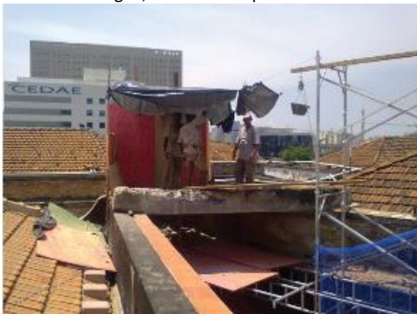
Figura 5 - Demolição de estruturas da caixa d'água, cobertura do prédio 07.
