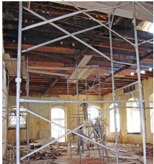
Figura 3 - Restauro das vigas de madeira do segundo pavimento
