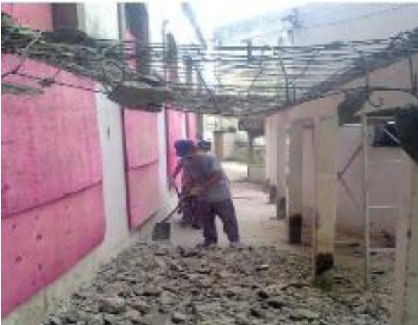
Figura 4 - Demolição de varanda posterior do prédio 01.
