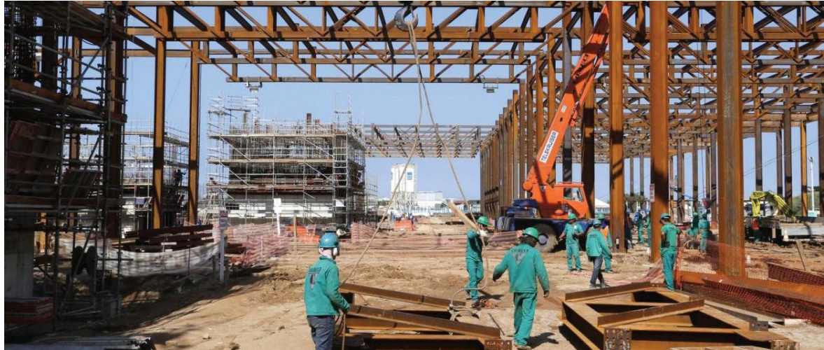
Figura 7 – Parque Olímpico - Estrutura metálica do prédio principal do Centro Internacional de Transmissão (IBC) é montada: o pé direito é de 12m, no primeiro andar, e de oito, no segundo
