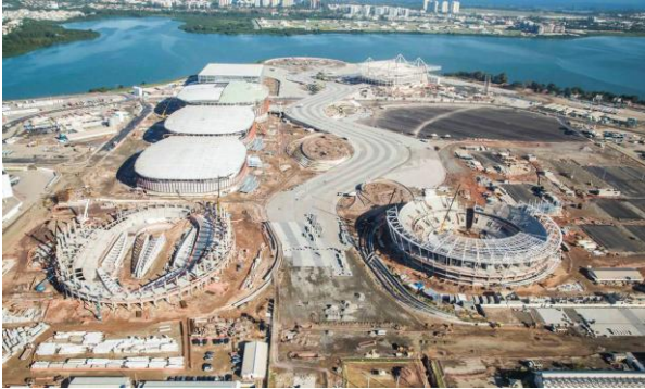
Figura 4 – Canteiro de obras Parque Olímpico
