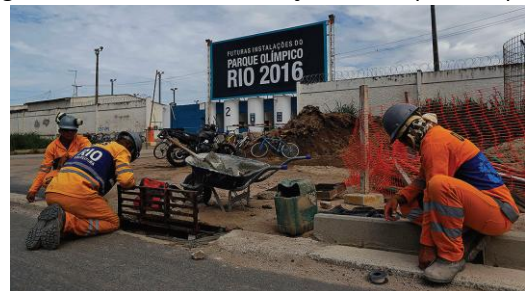
Figura 3 – Obras de urbanização do Parque Olímpico
