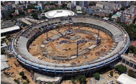
Figura 1 – Canteiro de Obras Estádio do Maracanã
