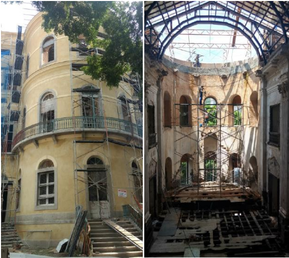
Figura 3 – Montagem da Reconstrução da Capela de São Pedro de Alcântara
