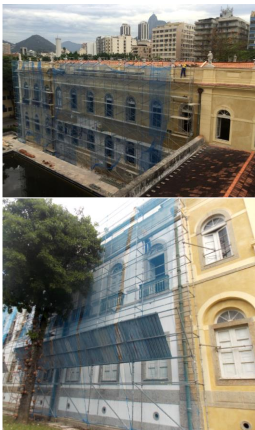
Figura 2 – Montagem da estrutura de andaimes fachadeiros
