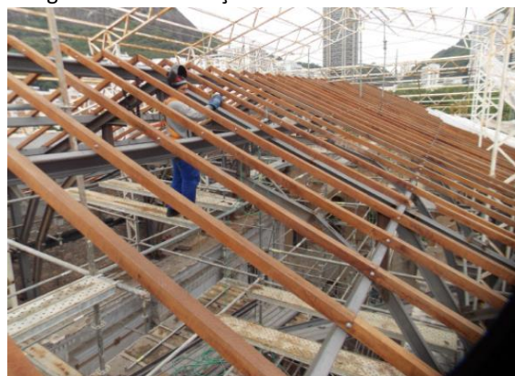
Figura 1 – Restauração da cobertura do telhado
