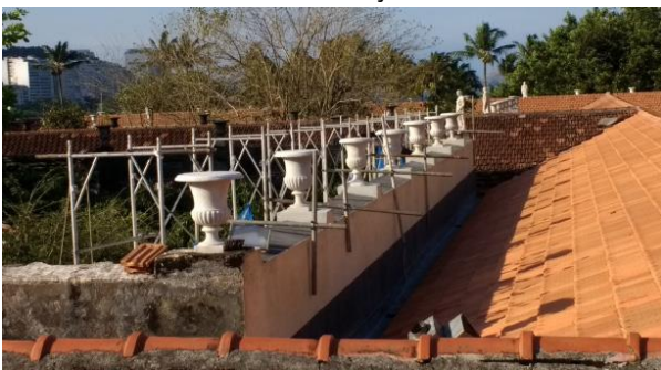
Figura 4 – Montagem dos elementos artísticos - peças são restauradas ou fabricadas no próprio canteiro. Detalhe para imagem do Cristo, reposicionada durante a reconstrução
