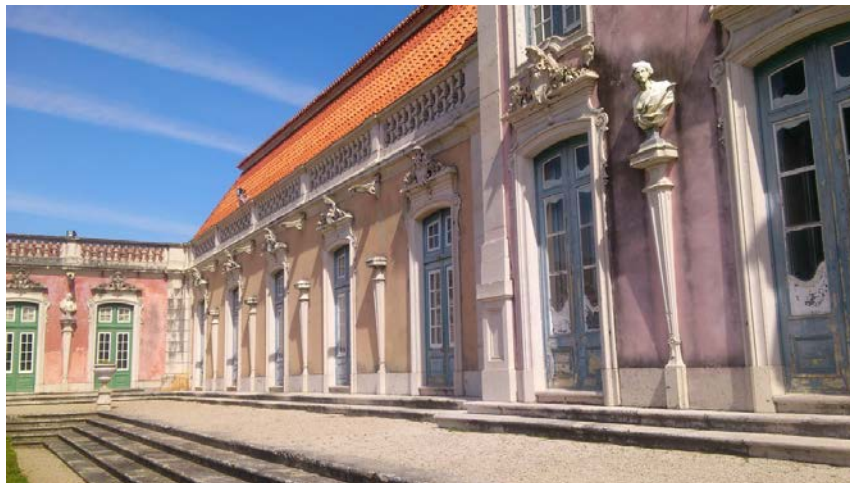
Figura 4 – Multiplicidade de cores e tons das fachadas e portas, antes da intervenção.
