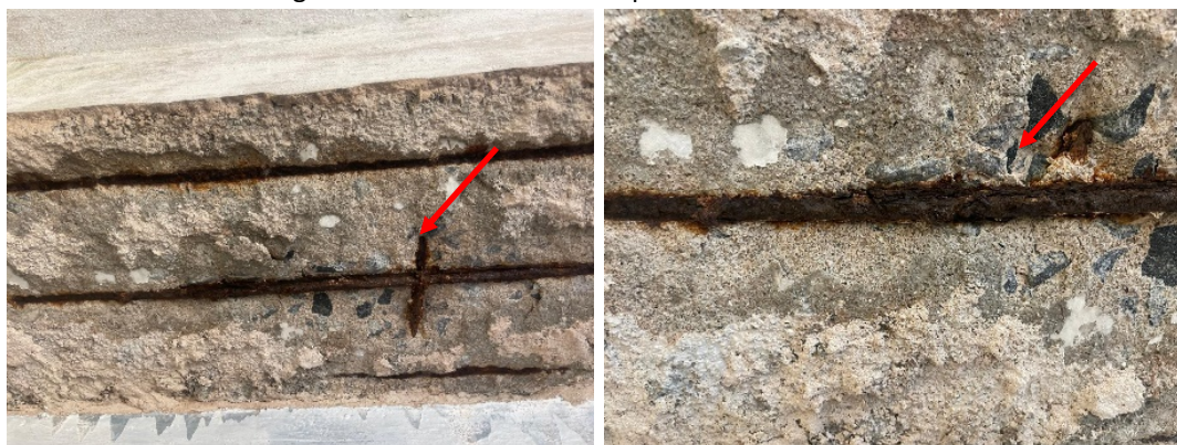
Figuras 6 e 7 – armaduras em processo de corrosão.
