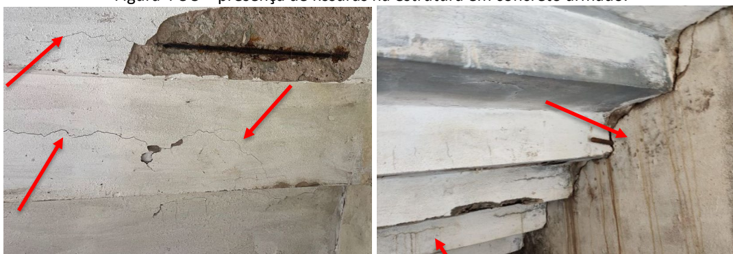
Figura 4 e 5 – presença de fissuras na estrutura em concreto armado.
