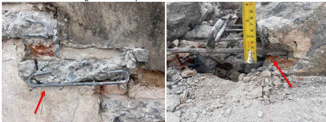
Figuras 8 e 9 – espessura do cobrimento de concreto
