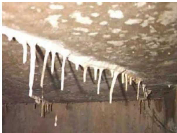
Figura 1 – Eflorescência em formato de estalactites.
