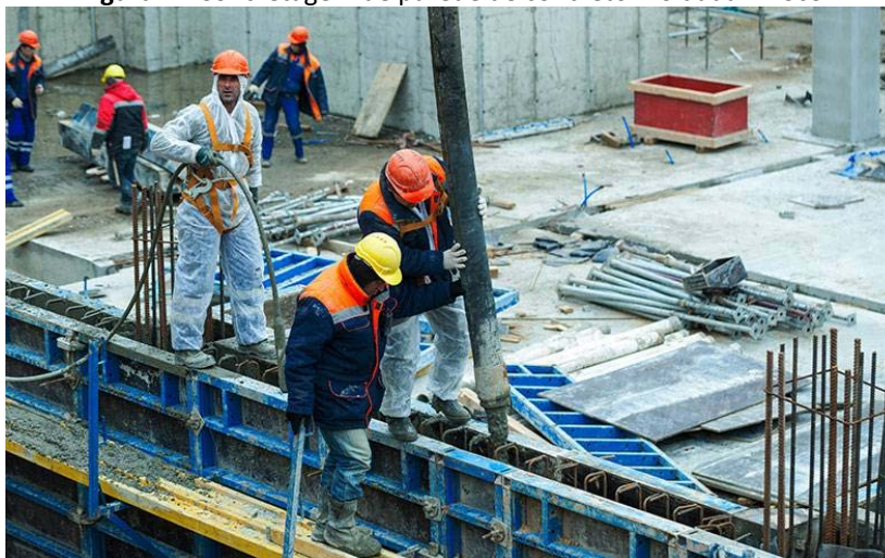
Figura 2 - Concretagem de parede de concreto moldada in loco
