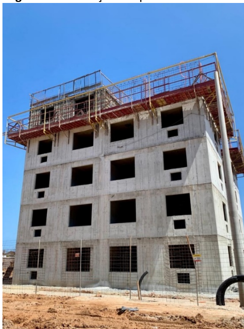
Figura 1 – Edificação em parede de concreto
