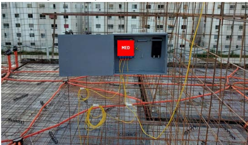
Figura 5 – Instalação dos equipamentos de maturidade
