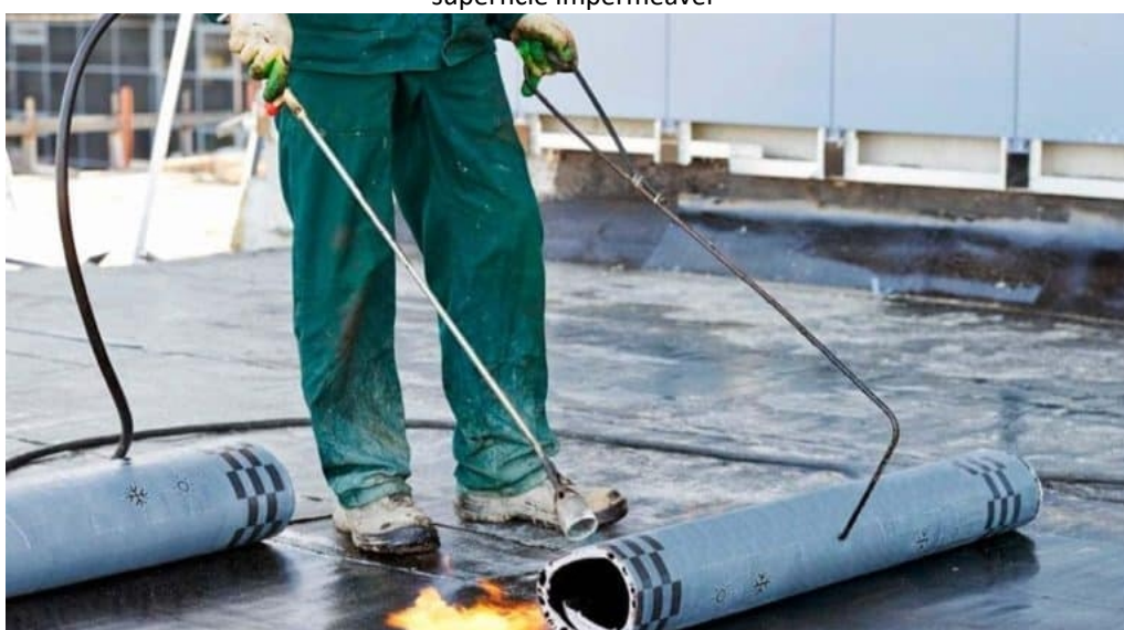
Figura 2 - Aplicação de manta asfáltica estruturada com poliéster flexível de alta resistência que deixa toda a superfície impermeável
