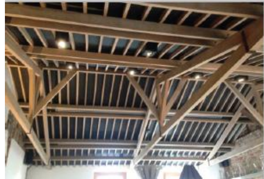
Figura 2 – Telhado do salão de entrada, em estrutura de madeira, foi deixado aparente
