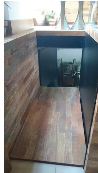
Figura 3 – Plataforma elevatória, no salão de entrada do restaurante
