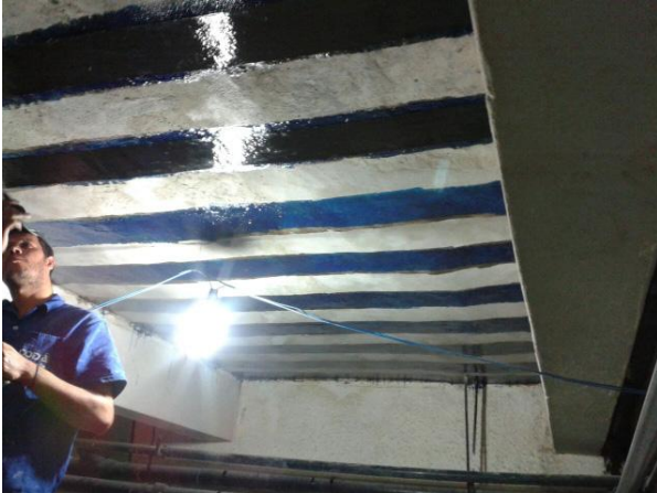
Figura 3 – Execução do reforço das lajes à flexão
