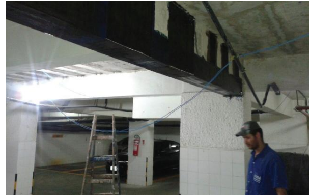
Figura 4 – Inserção de CFC da primeira camada nas vigas
