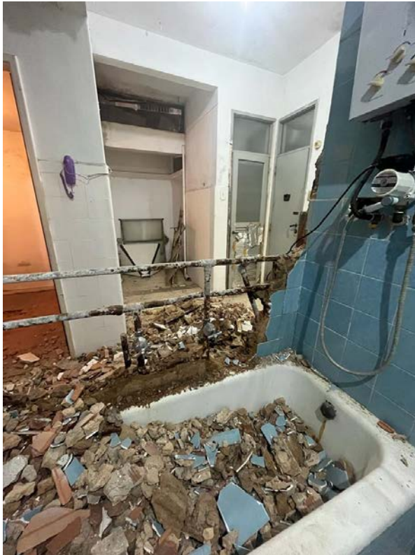
Figura 1: obra de pequeno porte
