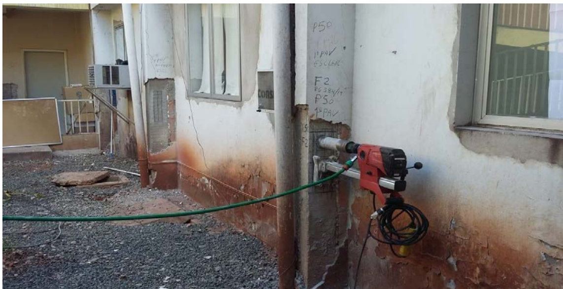
Figura 5 – Situação dos pilares da edificação
