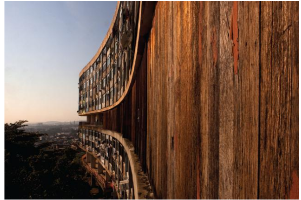
Figura 3 – Complexo do Pedregulho antes da reforma
