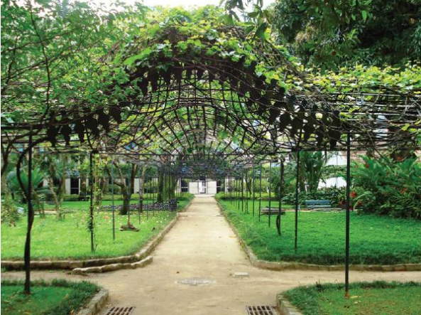
Figura 2 – Detalhe do parreiral em estrutura metálica
