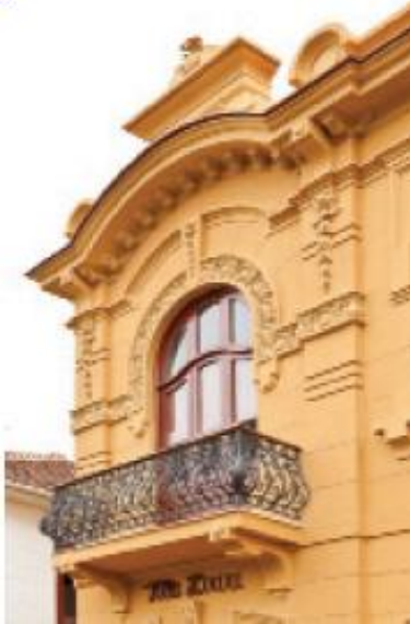
Figura 3 – Detalhe da fachada com cor ocre mantida
