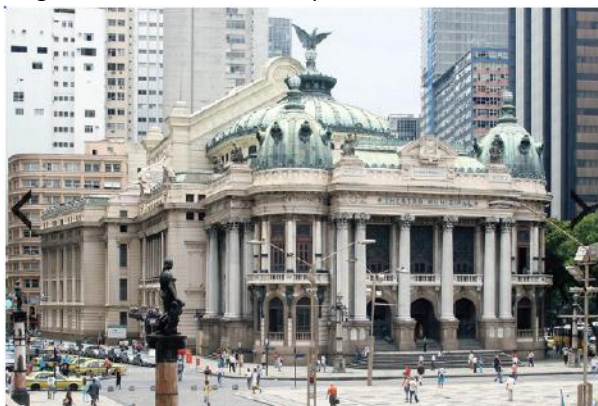
Figura 2 – Vista externa do prédio antes da reforma
