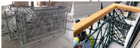
Figura 18 – Tratamento das guardas metálicas (antes e depois da intervenção)
