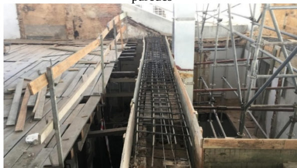
Figura 34 – Lintéis de coroamento para reforço das paredes
