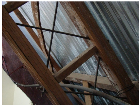
Figura 2 – Vista geral da cobertura, mostrando os arcos de madeira e as telhas metálicas
