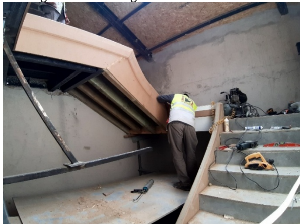
Figura 32 – Prolongamento da escada interior
