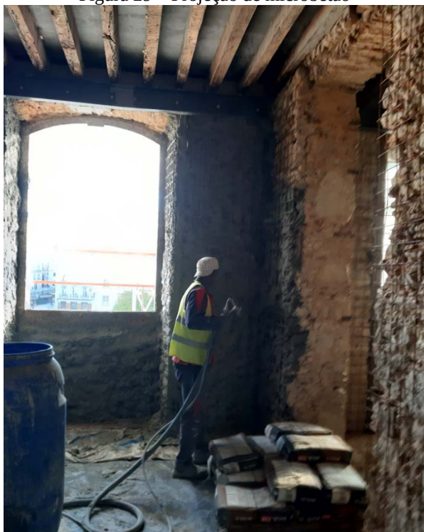
Figura 29 – Projeção de microbetão
