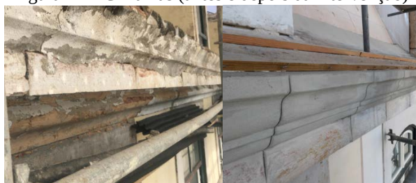
Figura 17 – Cimalthas (antes e depois da intervenção)
