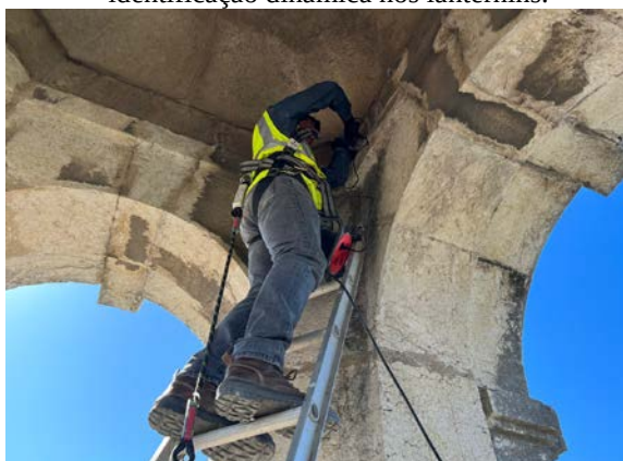
Figura 5 - Instalação do sistema de ensaio para identificação dinâmica nos lanternins.
