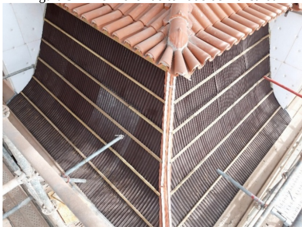
Figura 37 – Pormenor do telhado de mansarda
