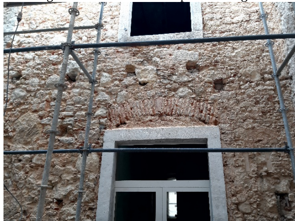
Figura 38 – Alvenarias em pedra do saguão
