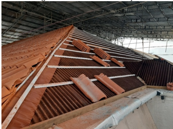
Figura 36 – Telhado em execução
