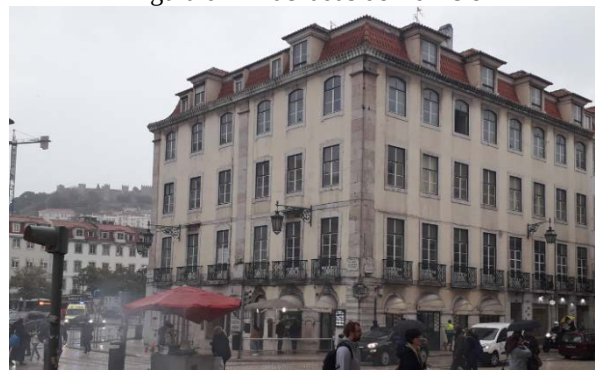
Figura 04 – Fachadas do Edifício
