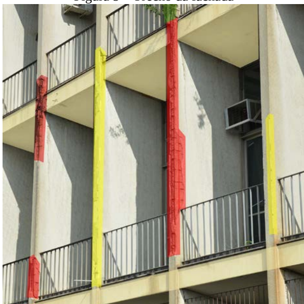
Figura 5 – Trecho da fachada
