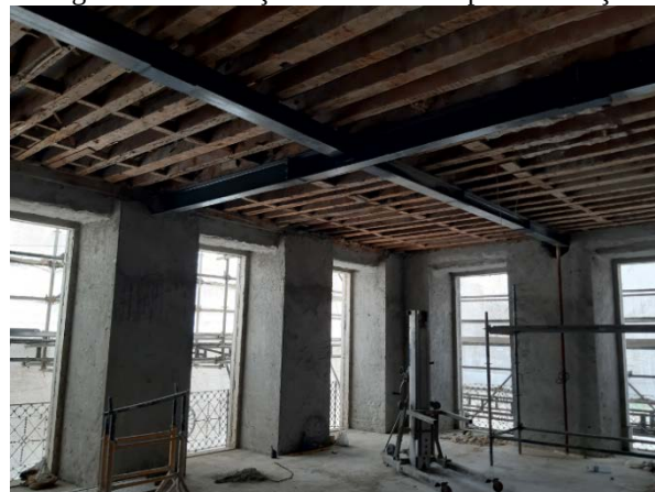
Figura 24 – Reforço estrutural com perfis em aço
