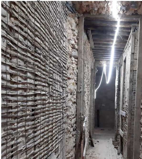
Figura 10 – Paredes em tabique
