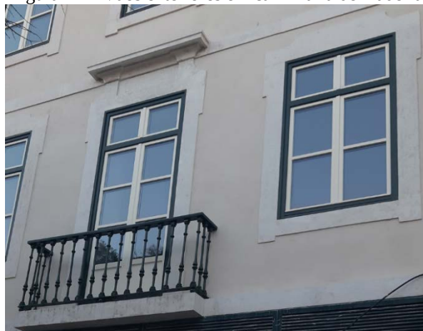
Figura 14 – Vãos exteriores em caixilharia de madeira
