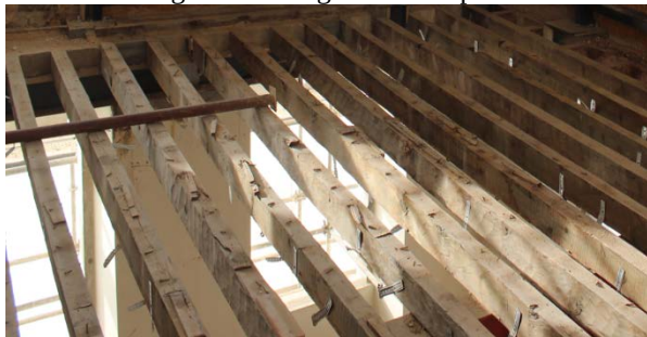
Figura 06 – Vigamento do piso
