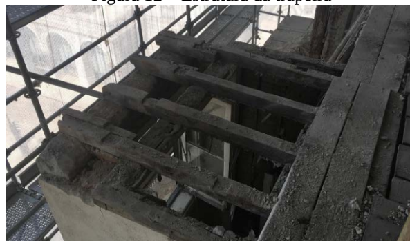
Figura 12 – Estrutura da trapeira
