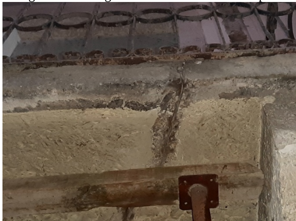
Figura 40 – Selagens de fissuras com resina époxi
