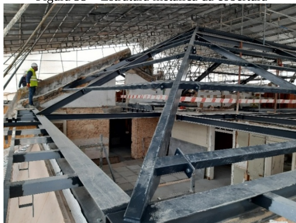
Figura 35 – Estrutura metálica da cobertura
