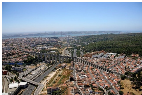
Figura 1 - Aqueduto das Águas Livres. Bairro da Serafina à direita e Campolide à esquerda, [23].
