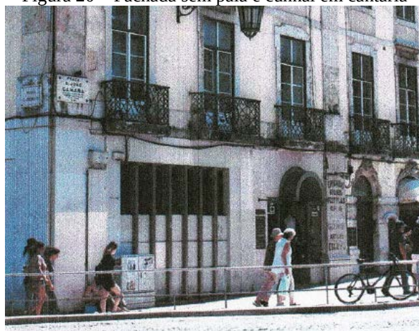
Figura 20 – Fachada sem pala e cunhal em cantaria
