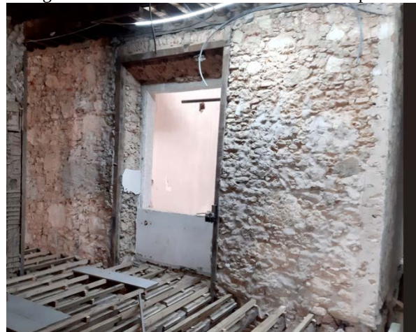
Figura 08 – Paredes exterior em alvenaria de pedra
