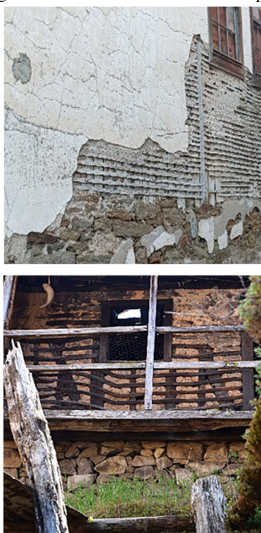
Figura 1 – Paredes exteriores de tabique
