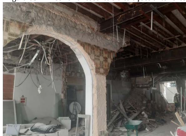
Figura 05 – Arco remanescente a alterações anteriores
