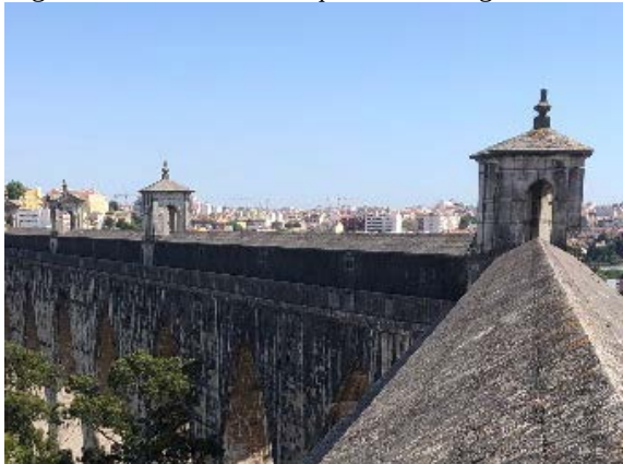
Figura 2 - Lanternins do aqueduto das Águas Livres.
