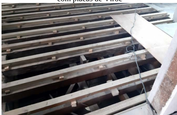
Figura 26 – Nivelamento dos pisos e assoalhamento com placas de Viroc
