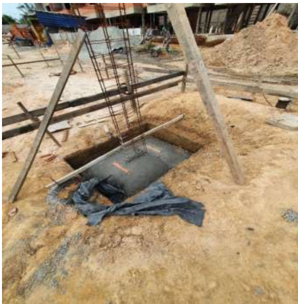
Figura 7 – Execução das sapatas após eliminação das etapas com desperdícios.
