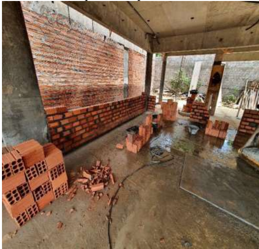
Figura 8 – Separação e organização de alvenaria para paredes e painéis.
