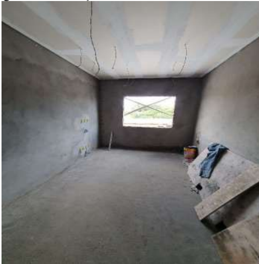
Figura 9 – Execução de reboco com aditivo colante.
