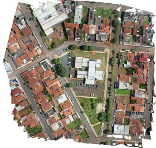
Figura 3 – vista área da implantação da edificação
