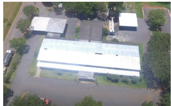
Figura 6 – Vista aérea UBS 01
