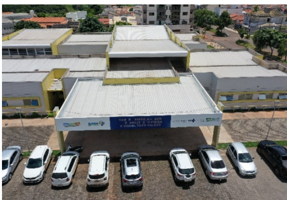
Figura 2 - Acesso principal do CER Patos de Minas.
