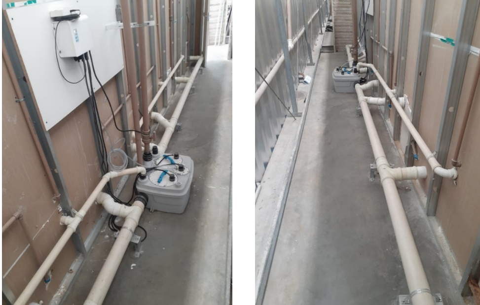
Figura 18 e 19 – Equipamento Sanicubic 2 recebendo 8 saídas simultâneas de bacias sanitárias
