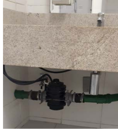
Figura 3 – Válvula de descarga DN32
