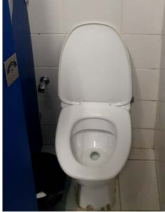
Figura 1 – Bacia sanitária de sistema a vácuo
