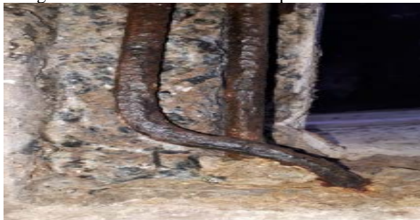
Figura 6: Detalhe da armadura do pilar do subsolo.
