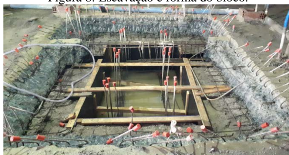
Figura 8: Escavação e forma do bloco.
