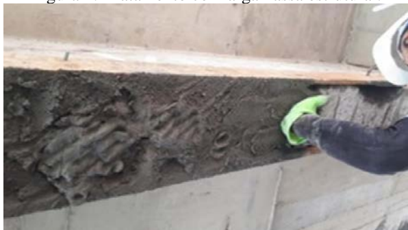
Figura 4: Tratamento com argamassa estrutural.
