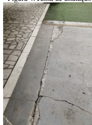
Figura 4: Junta de dilatação
