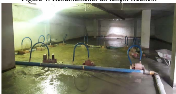
Figura 4: Rebaixamento do lençol freático.
