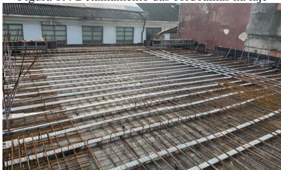
Figura 19: Detalhamento das cordoalhas na laje
