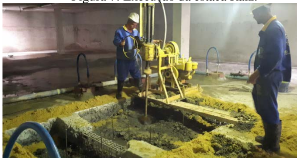
Figura 7: Execução da estaca Raiz.
