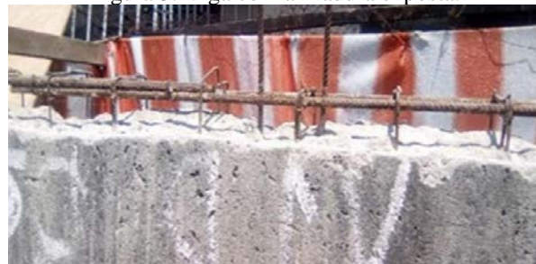
Figura 3: Viga com armadura exposta.
