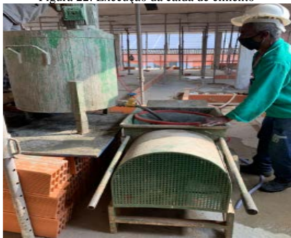
Figura 22: Execução da calda de cimento
