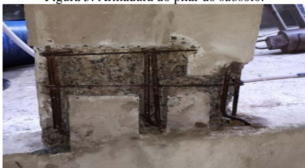
Figura 5: Armadura do pilar do subsolo.
