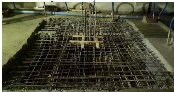
Figura 9: Armação do bloco.
