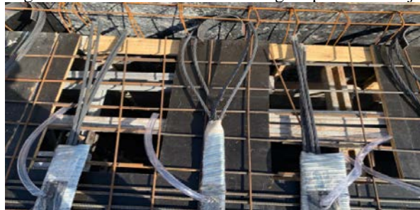
Figura 16: Detalhamento da ancoragem passiva na laje
