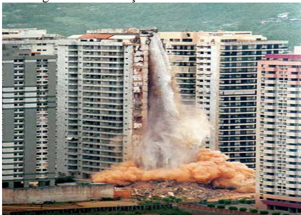
Figura 1 – Destruição do edifício Palace II
