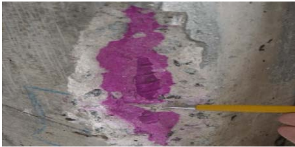
Figura 7 – Teste de Fenolftaleína no concreto
