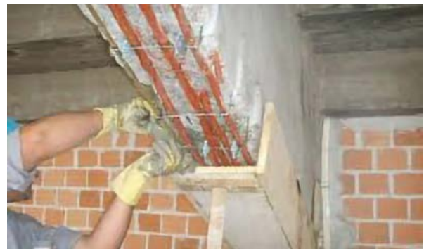
Figura 5 – Restauração da região desagregada
