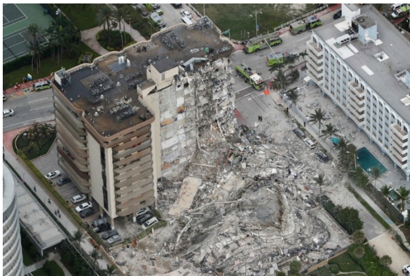
Figura 8 – Prédio de 12 andares que desabou parcialmente na região de Miami
