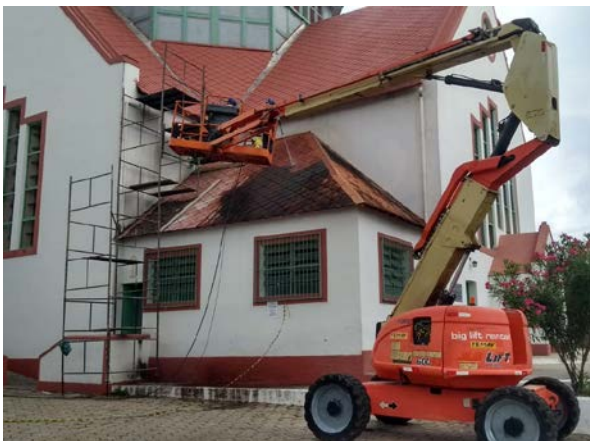
Figura 4 – Uso de plataforma e andaimes durante a obra
