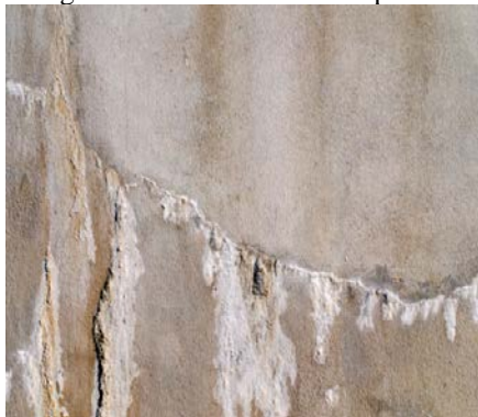
Figura 5 – Eflorescência em parede
