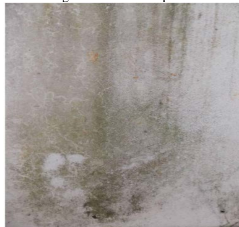
Figura 4 – Mofo em parede
