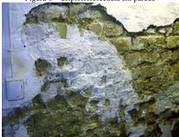
Figura 6 – Criptoflorescência em parede
