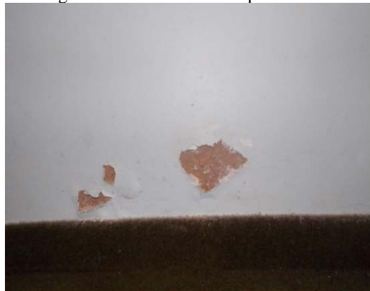
Figura 8 – Descascamento por umidade
