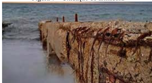
Figura 7 – Oxidação de armadura
