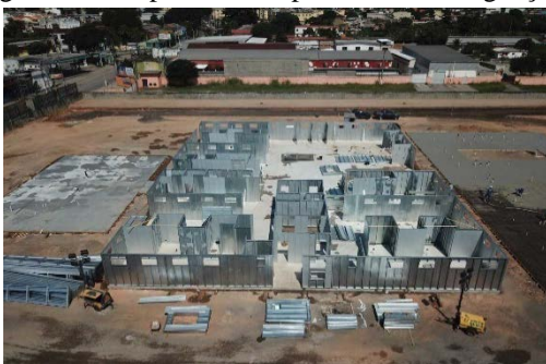
Figura 3 – Hospital de campanha de Nova Iguaçu
