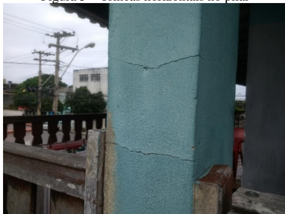
Figura 5 – Trincas horizontais no pilar
