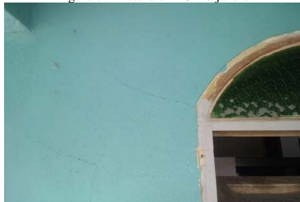
Figura 7 – Fissura em 45° na janela
