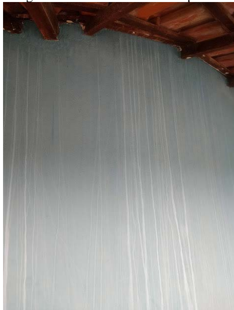
Figura 4 – Manchas brancas na parede
