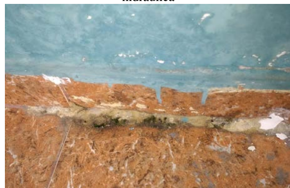
Figura 3 – Infiltração por vazamento de instalação hidráulica
