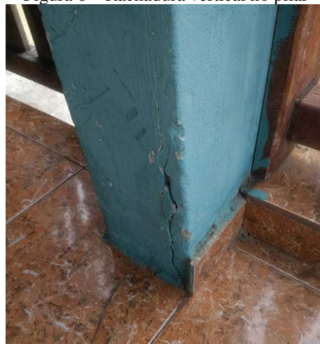
Figura 6 – Rachadura vertical no pilar
