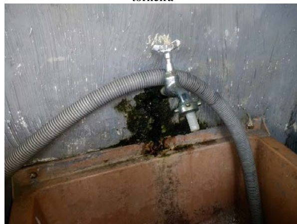
Figura 2 – Vazamento da conexão entre a tubulação e a torneira
