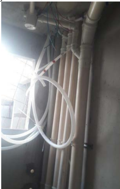
Figura 5 – Shaft de Hidráulica no Banheiro
