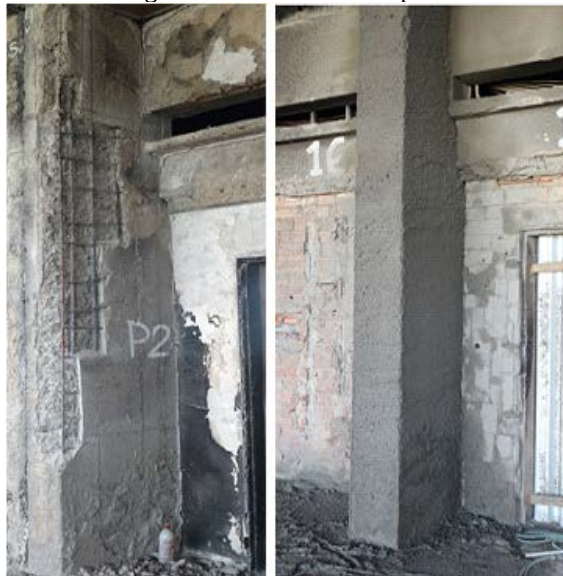
Figura 3 – Tratamento de pilar
