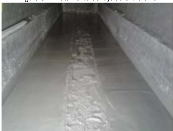
Figura 8 – Tratamento de laje do entreferro
