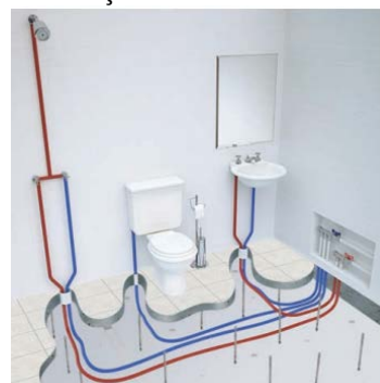
Figura 3 – Instalação do Sistema PEX Ponto a Ponto
