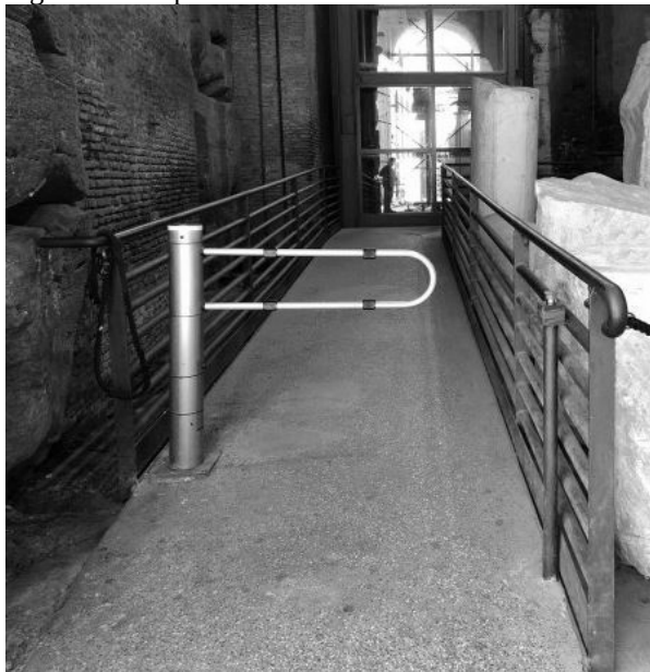
Figura 3: Rampa em rota acessível no Coliseu de Roma
