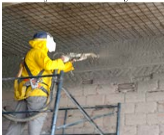
Figura 4 – Tratamento de viga
