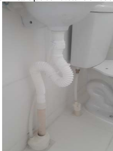
Figura 8 – Instalação do Lavatório e Bacia Sanitária
