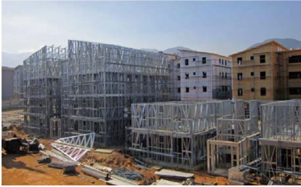
Figura 2. Steel frame estrutura
