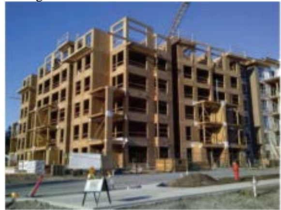
Figura 4. Casa americana em wood frame
