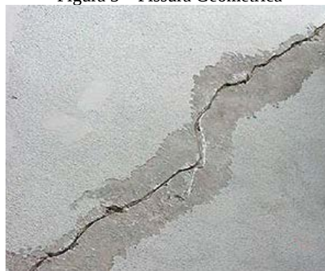
Figura 3 – Fissura Geométrica
