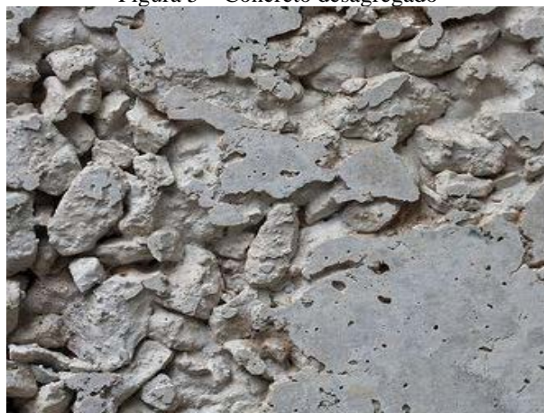
Figura 5 – Concreto desagregado
