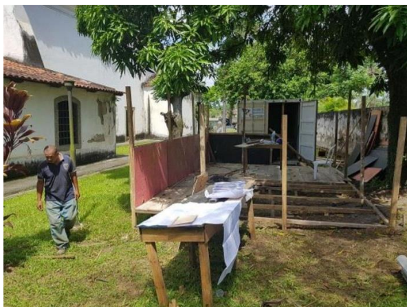
Figura 8 – Montagem de galpão para refeitório de funcionários no dia 31/01/2020.
