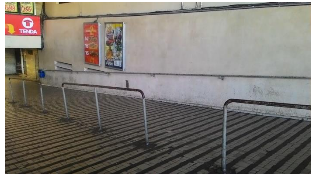
Figura 13 – Corrimão padrão do Edifício da Central do Brasil.
