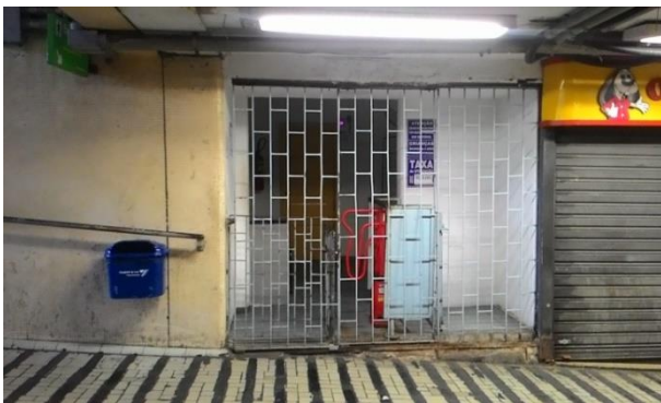
Figura 19 – Entrada do banheiro masculino com cabine acessível.
