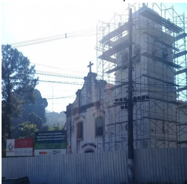
Figura 6: Estado da fachada frontal da edificação em 10/08/2020 – Restauração da torre
