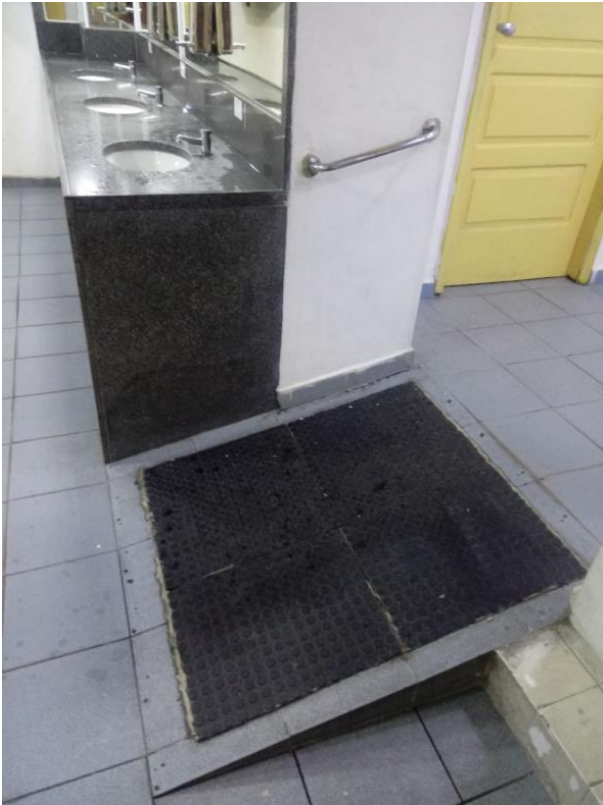
Figura 22 – Rampa de acesso com corrimão
