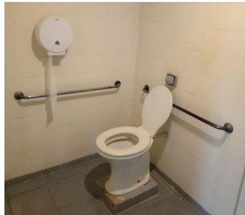
Figura 20 – Cabine do banheiro para cadeirantes. Área da bacia sanitária.
