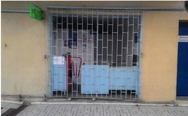
Figura 18 – Entrada do banheiro feminino com cabine acessível.
