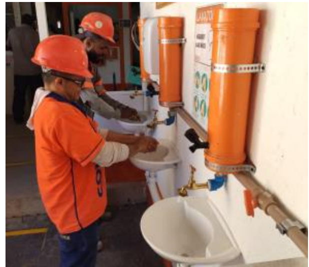
Figura 3: Lavatórios na entrada, no refeitório e vestiários.
