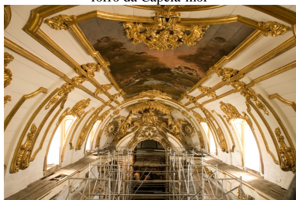
Figura 10: Andaimes para restauro de pintura no forro da Capela-mor
