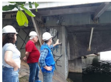
Figura 6 - Inspeção para avaliação estrutural
