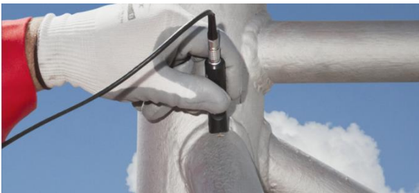
Figura 2 – Inspeção com uma sonda por correntes parasitas em uma estrutura metálica [5]
