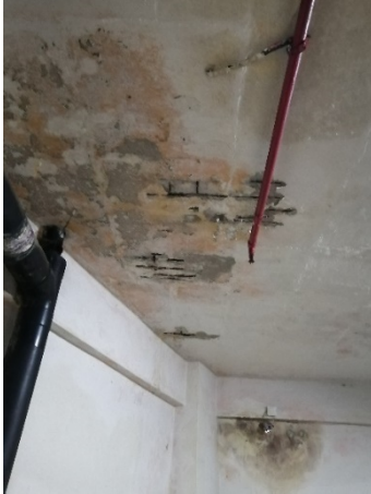
Figura 6: Teto da laje do pavimento térreo
