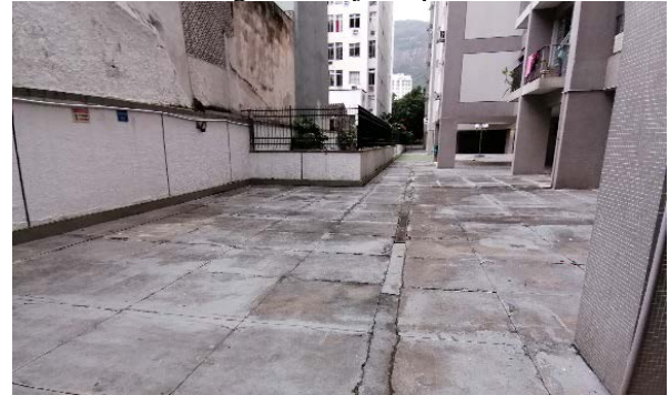
Figura 2: Laje do piso
