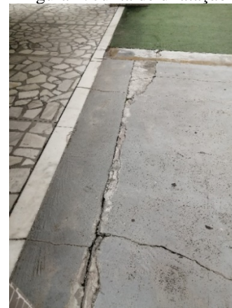
Figura 4: Junta de dilatação
