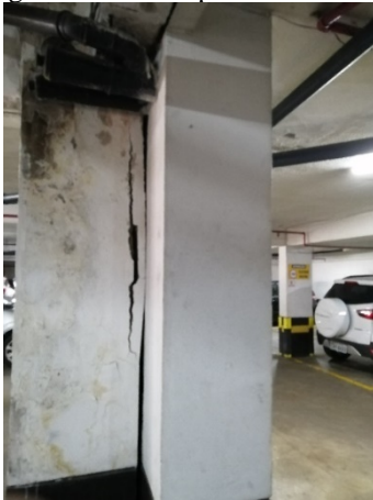
Figura 7: Pilar do pavimento térreo
