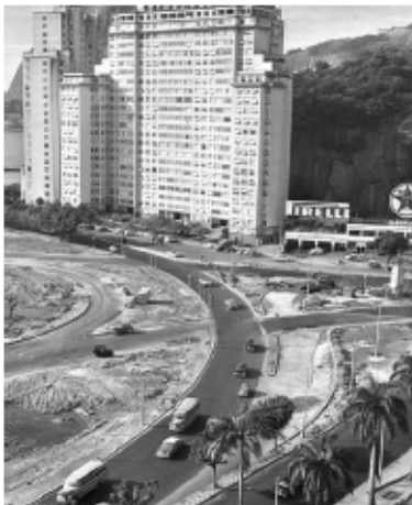
Figura 2: Edifício ao fundo, durante as obras do Aterro do Flamengo, em 1961.
