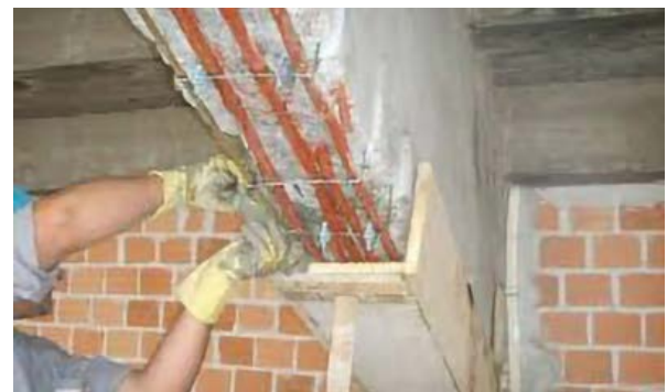
Figura 5 – Restauração da região desagregada
