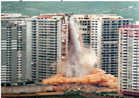
Figura 1 – Destruição do edifício Palace II
