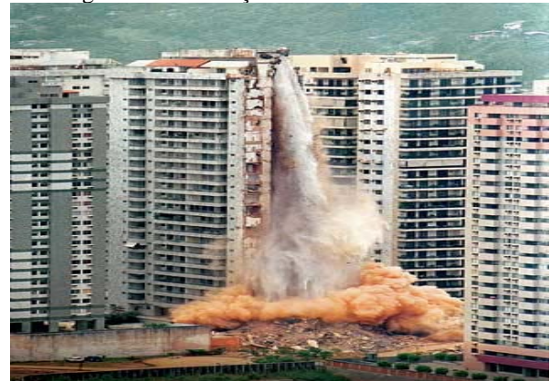
Figura 1 – Destruição do edifício Palace II
