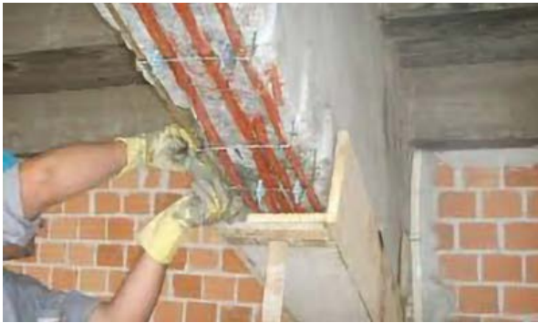
Figura 5 – Restauração da região desagregada
