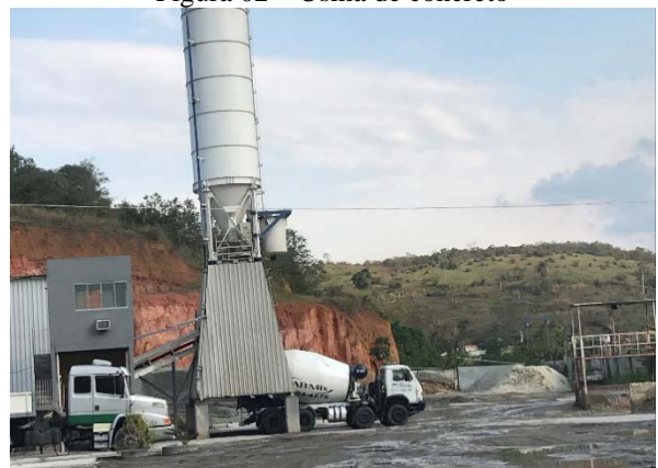
Figura 02 – Usina de concreto
