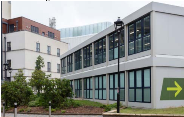
Figura 4. Edifício Modular LHC
